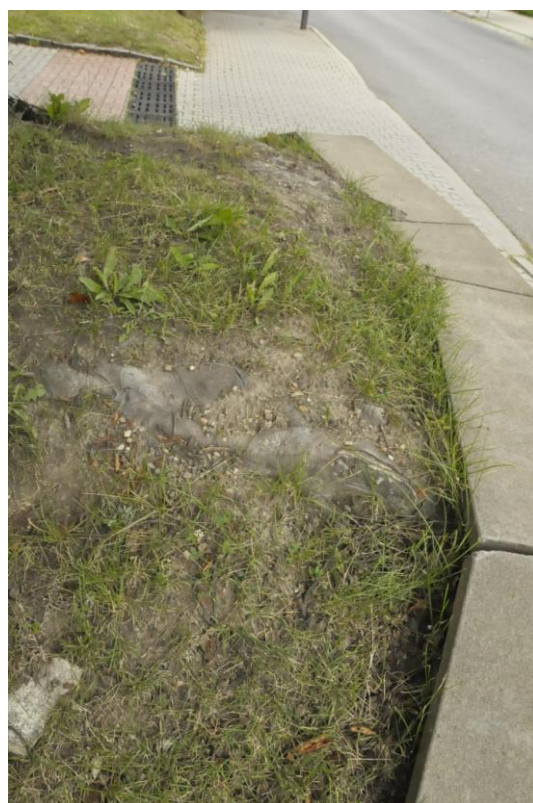
Foto 16 – kořeny na jižní straně (pohled z-v)
